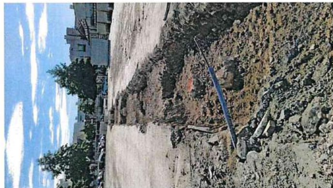
Illustration 38 : ligne de pieux, terrassement avant recépage (septembre 2020)
