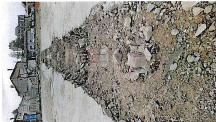
Illustration 38 : ligne de pieux, terrassement avant recépage (septembre 2020)
