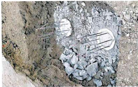
Illustration 39 : recépage de pieux avant/après (09/12/2020)
