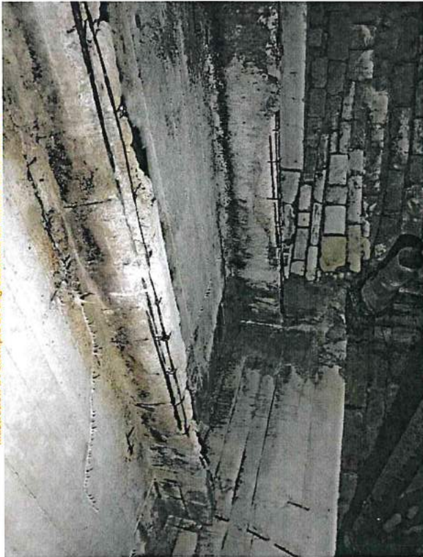
Illustration 1 : exemple de dégradations au niveau de la dalle n°2
