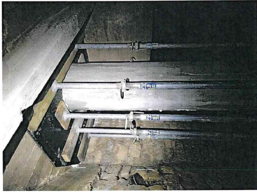
Illustration 41 : pieux 18" recépé et béton coulé
