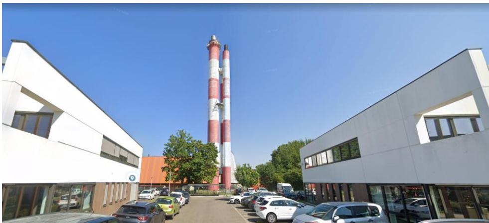
Illustration n° 12 : Vue de la cheminée depuis le sol
