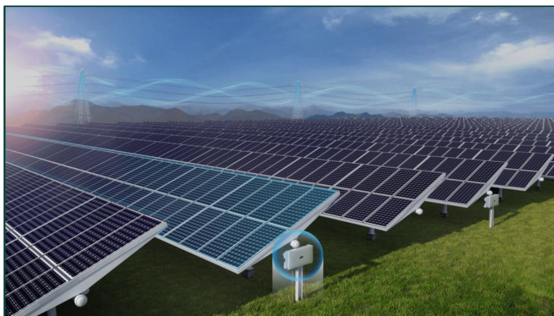
Figure 8 – Schéma de principe – localisation onduleurs décentralisés (© Électricité d'Azur)
