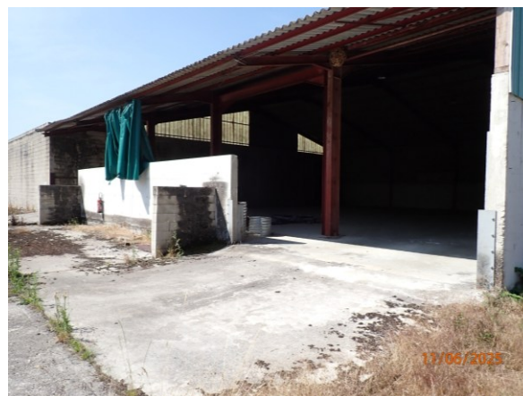
Photo 2 – Bâtiment industriel désaffecté à l'Est du périmètre du projet (Alisea / Fabien Potestat)
