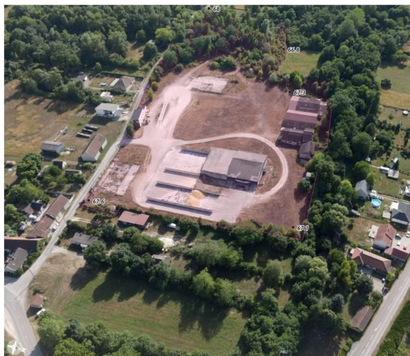
Figure 3 – Vue du dessus du site industriel étudié (© Électricité d'Azur)
