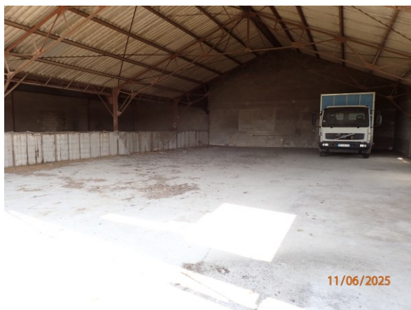
Photo 1 – Bâtiment industriel désaffecté au Nord du périmètre du projet (Alisea / Fabien Potestat)
