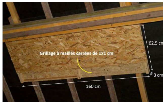
Gîte à oreillards constitué de plaques OSB, dont l'une est recouverte à l'intérieur d'un grillage
