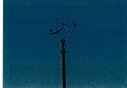
Réduire le risque de percussion/électrisation par amélioration de la **visibilité** de l'ouvrage : pose de dispositifs avertisseurs à haute visibilité :
