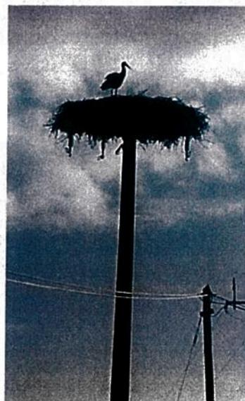
4°) **Haudrecy**, suite à un signalement et après validation de la LPO, Enedis a installé des dispositifs de sécurisation avec des protecteurs de ligne, des ponts gainés, la mise en place de rallonge pour éloigner les câbles du nid le 06/04/2017.
