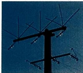
Les tiges installées sur le poteau doivent empêcher les cigognes de se poser et de débiter la construction d'un nouveau nid à l'endroit du nid déplacé.
