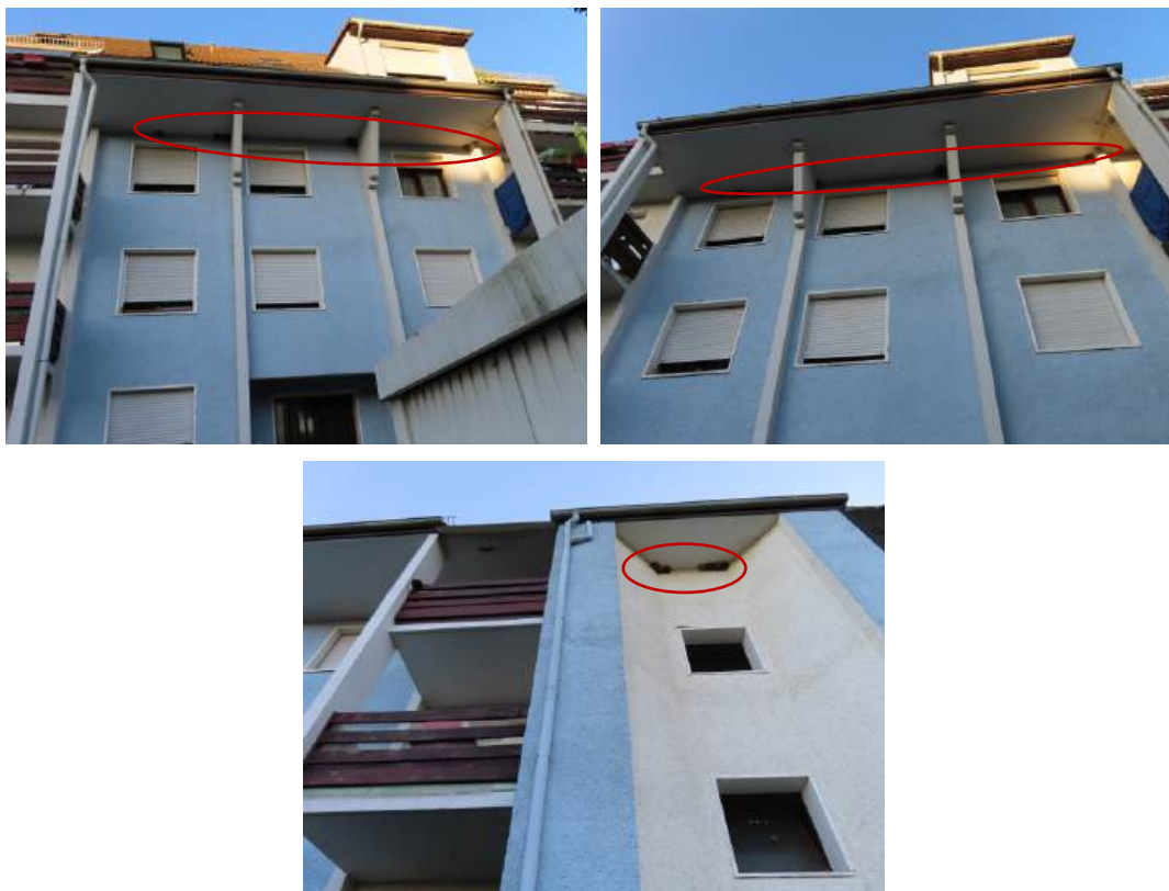
Figure 12 : Zones de nidification de l'Hirondelle de fenêtre sur le bâtiment 5
