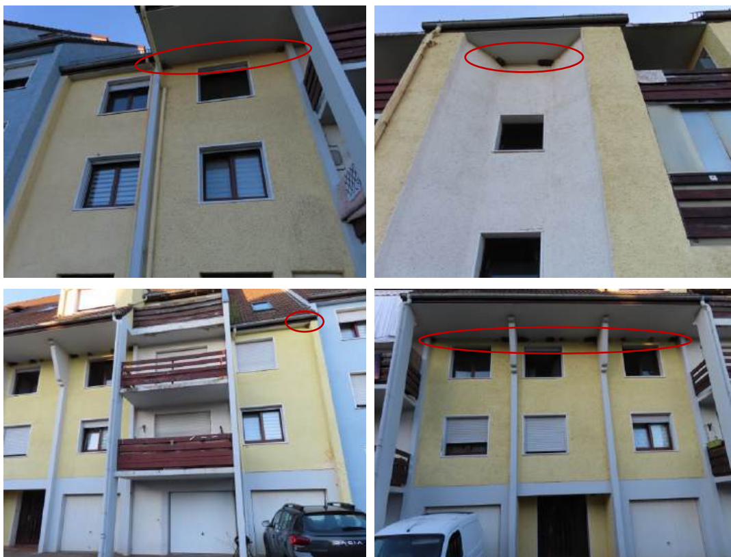
Figure 15 : Zones de nidification de l'Hirondelle de fenêtre sur le bâtiment 7
