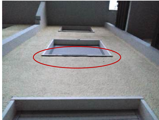
Figure 9 : Cornière en dessous des fenêtres
