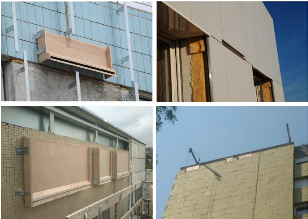
Figure 27 : Gîte artificiel intégrés dans l'isolant (source : Nature Nichoirs)
