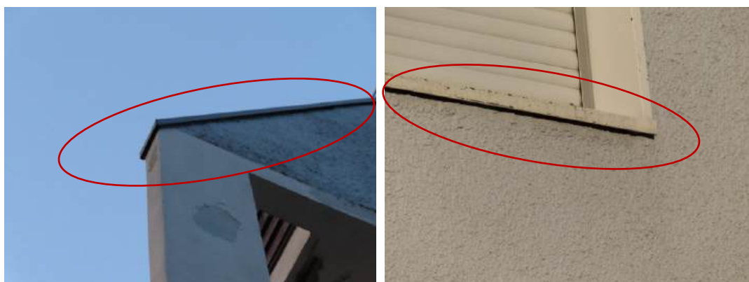
Figure 4 : Cornière en dessous des fenêtres et couvertines
