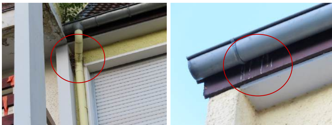
Figure 16 : Zones de nidification du Moineau domestique sur le bâtiment 5
