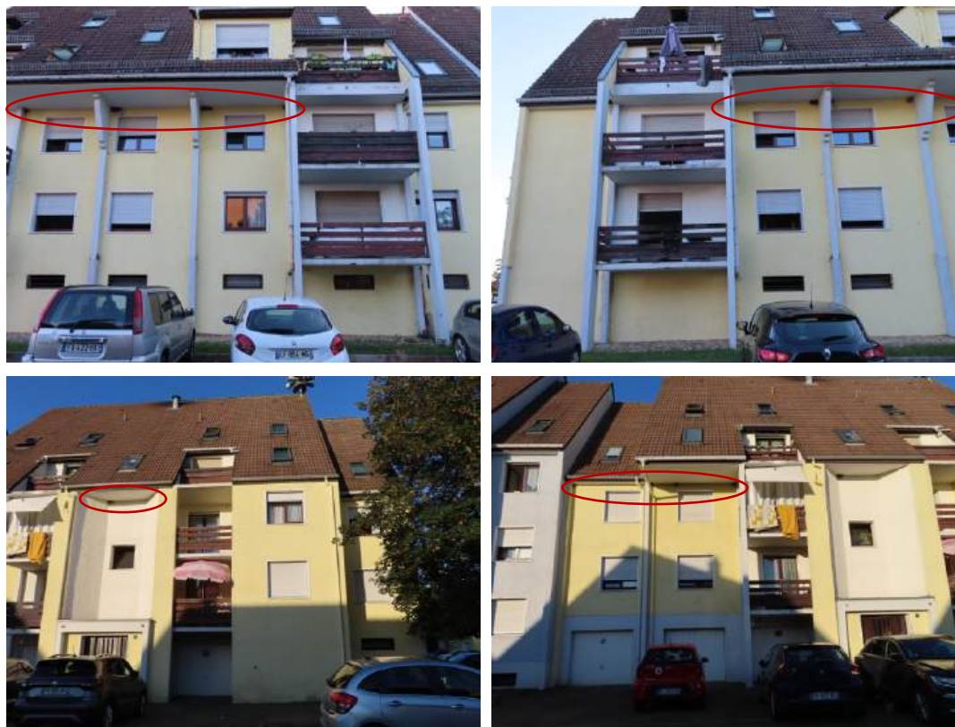
Figure 5 : Zones de nidification de l'Hirondelle de fenêtre sur le bâtiment 1
