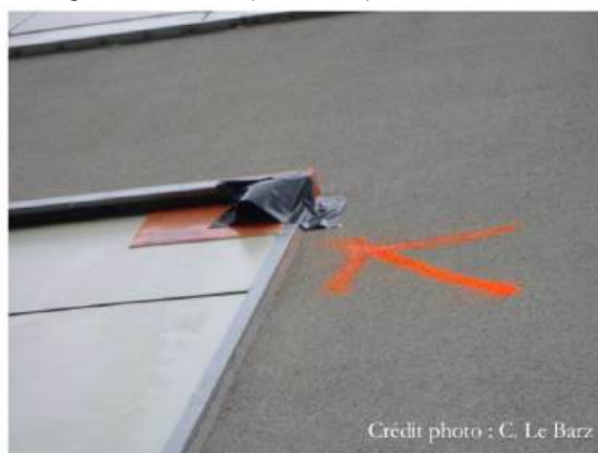
Figure 23 : Exemple de dispositif anti-retour
