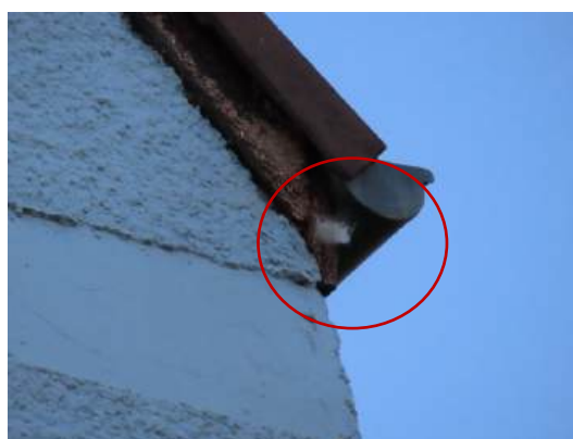
Figure 13 : Zones de nidification du Moineau domestique sur le bâtiment 5
