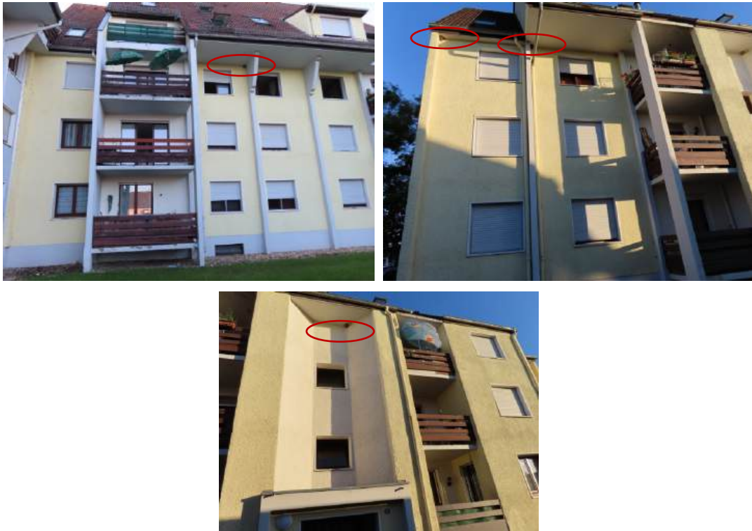
Figure 10 : Zones de nidification de l'Hirondelle de fenêtre sur le bâtiment 5
