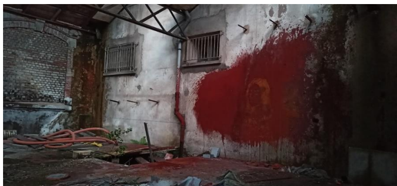
Entrée 2 : Intérieur du bâtiment
