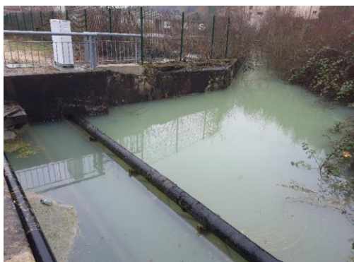
Vue extérieure du tunnel le 30/01/2021 © H. POIRSON
