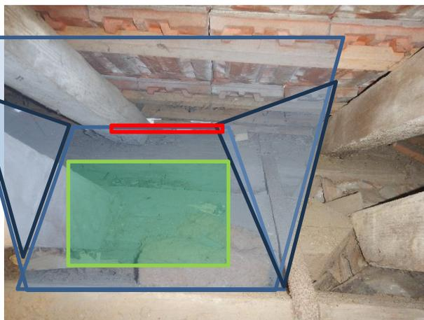
exemple d'aménagement de niche proposé (caisson en bleu, trappe de contrôle en vert, latte à retirer en rouge)
