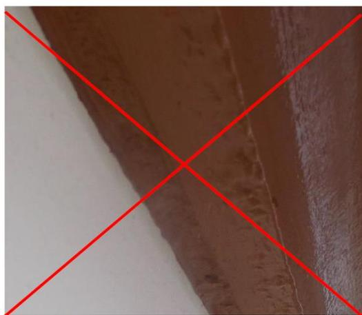
Accès fermés par de la mousse polyuréthane et par du silicone
