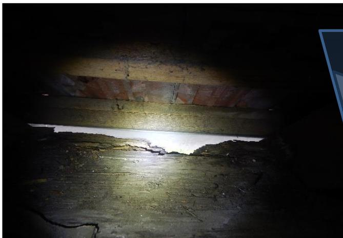
Illustration d'un espace entre les lattes à toit, la corniche et la gouttière
