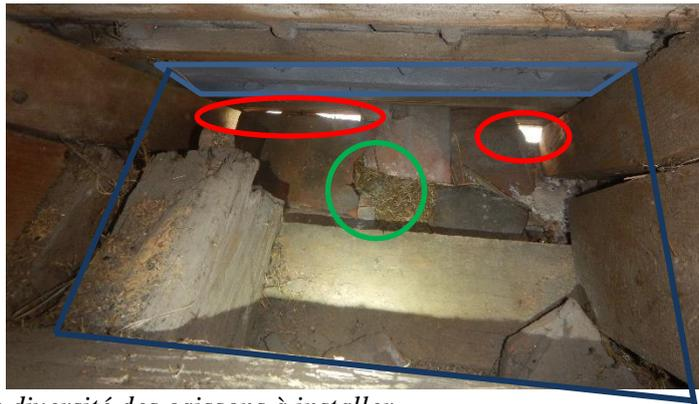
*Illustration de la diversité structurelle des loges et de la diversité des caissons à installer (nid en vert – accès en rouge – caisson bleu)
