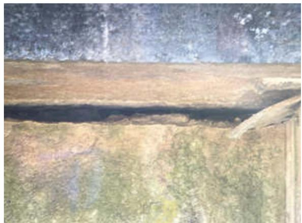
Ces interstices sont présents de façon irrégulière le long du parapet au gré des dégradations des jointures des pierres de taille constituant les corbeaux et les trottoirs.
