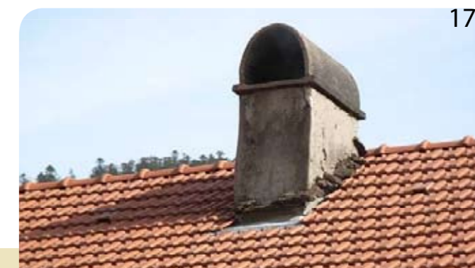
La cheminée maçonnée subsiste, ainsi que ses rives en dalles qui formaient jadis les joints avec les bardeaux de toiture.
