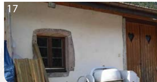
La porte charretière fait la hauteur du mur gouttereau, avec un linteau droit et deux ouvrant en planches verticales.
