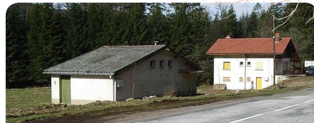
Secteur de la Grange Moselaine Exemple d'adaptation des recommandations au bâti existant
