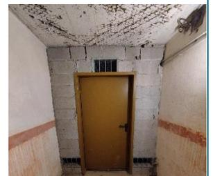
Figure 15 : Grillage au-dessus des porte des couloirs à remplacer par des barreaux horizontaux.
