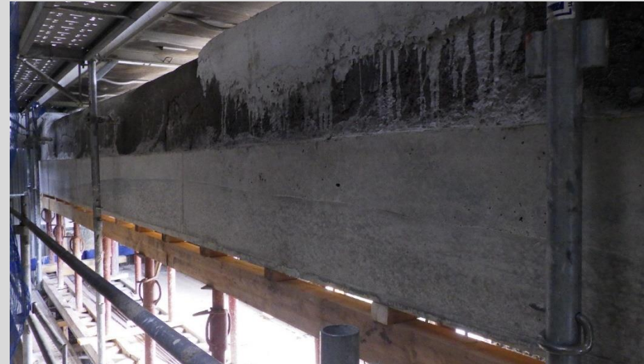
Reconstitution de la structure après traitement des aciers et réfection de l'ossature métallique
