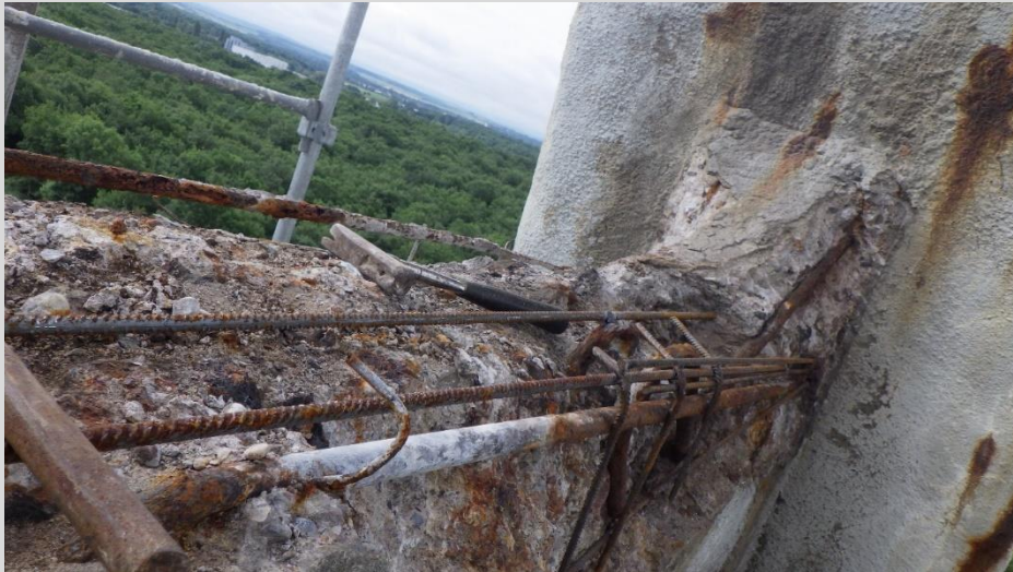
Purge de la structure au marteau piqueur
