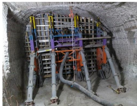
Coffrage final + injection BAP
