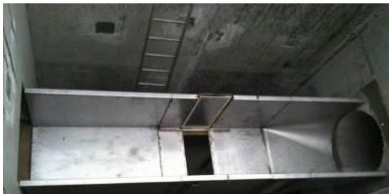
Figure 95 : Photo d'un piège à charriage à Marseille
