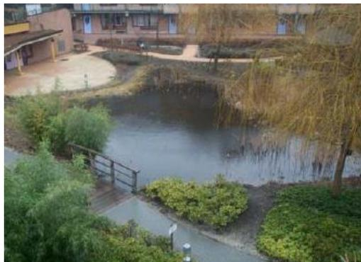
Figure 44 : Marre d'infiltration (Rombaut, 2010)
