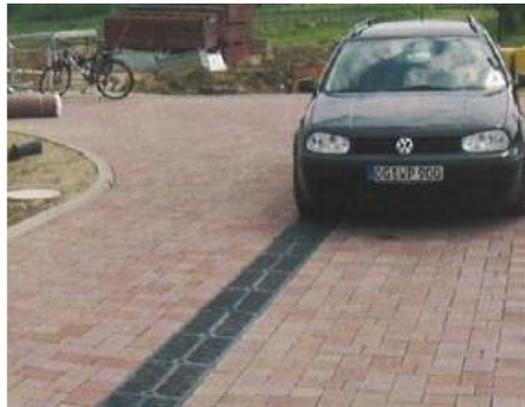
Figure 48 : Exemple de caniveau filtrant infiltrant (Funke)
