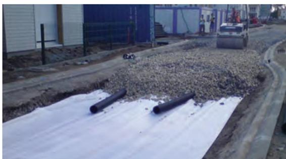
Figure 64 : Chaussée à structure réservoir - photo : (Syndicat Intercommunal du Bassin d'Arcachon, 2013)
