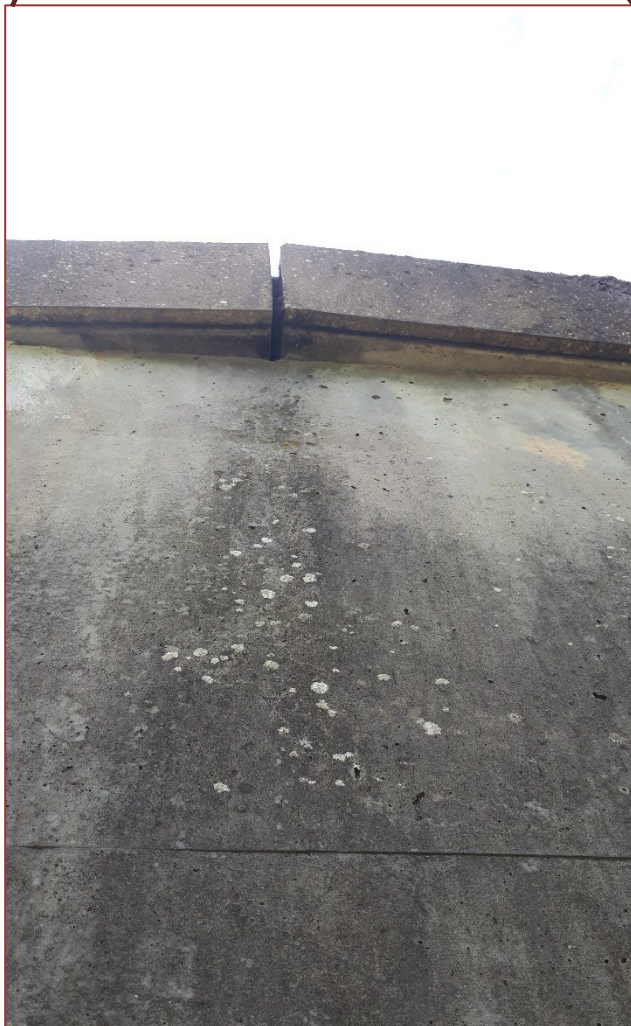
FIGURE 8 : GROS PLAN SUR UN DES JOINTS DE DILATATION
