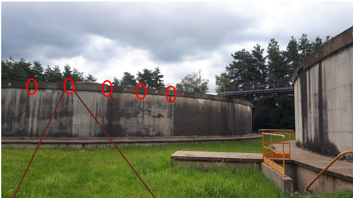
FIGURE 7 : LOCALISATION DES JOINTS DE DILATATION
