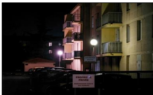
Figure 9 : luminaire de type "boule", à remplacer d'ici 2025 en raison de son émission importante de lumière vers le ciel (10)
