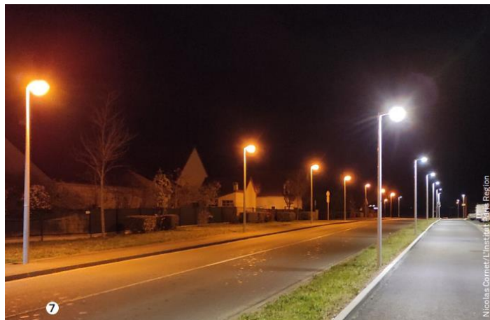
Figure 11 : exemple de rue intégralement éclairée (53)
