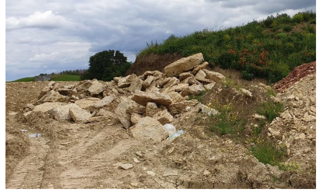
Plaquettes calcaires extraits lors des terrassements de la plateforme de Thal-Drulingen
