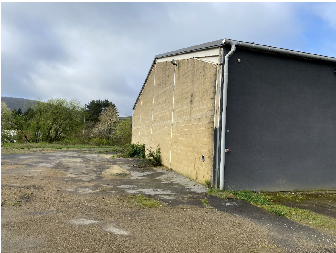
Photos 1 et 2 : Vue générale extérieure du bâtiment (Façade et arrière)
