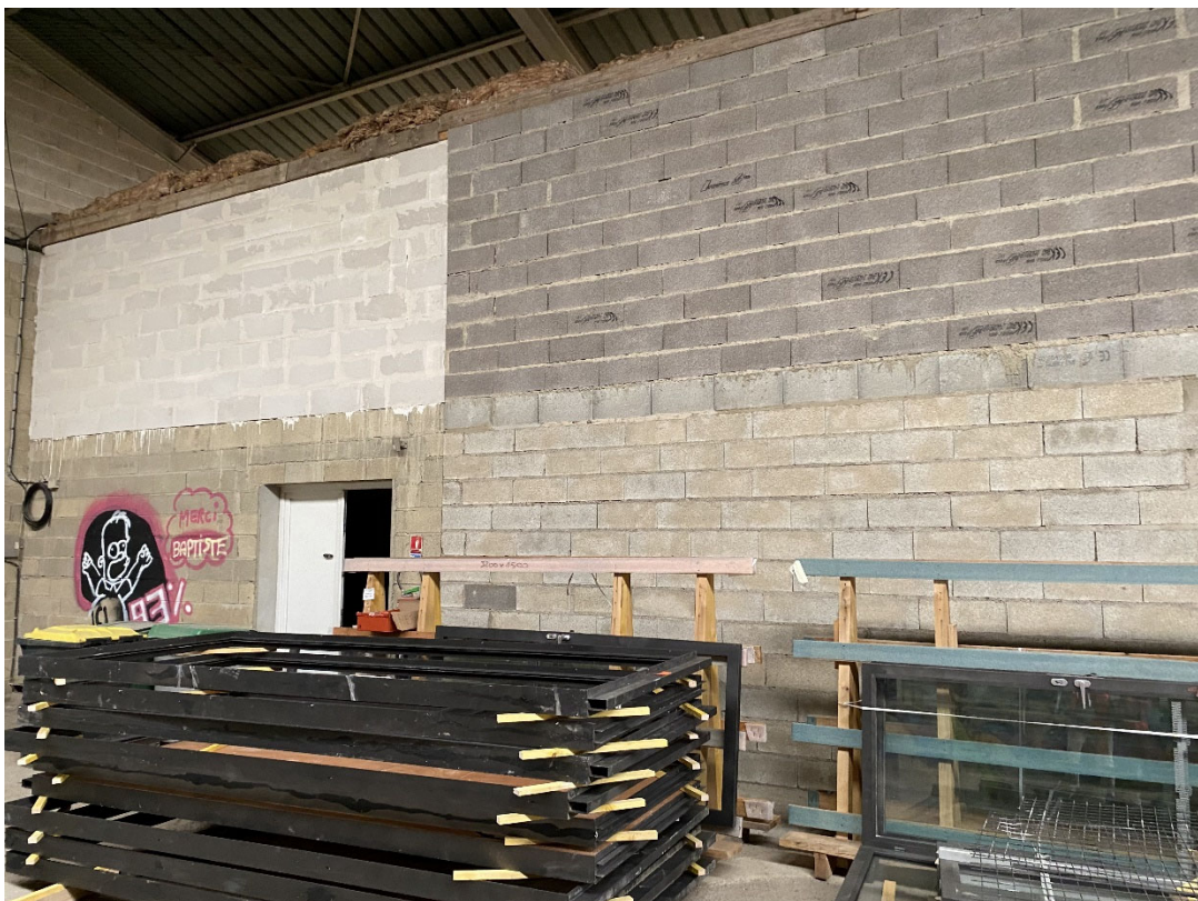
Photos 3 et 4 : Vues de l'intérieur du bâtiment
