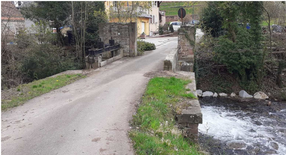
Vue de dessus de l'ouvrage
