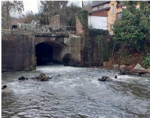
Vue aval de la prise d'alimentation
