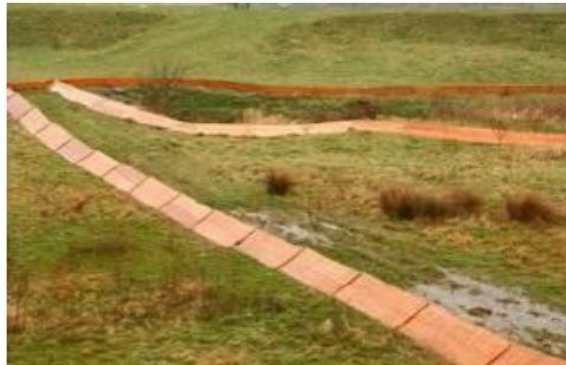
Figure 2 : Photo d'une barrière anti-retour
