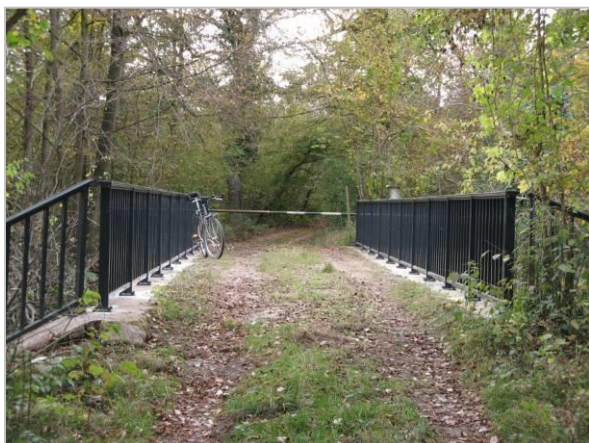
5- Le garde corps du pont des capucins après avoir été remplacé.
