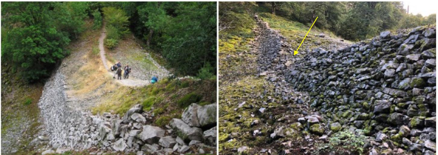
À gauche, le parement-ouest, encore assez stable (État 2019 – Rapport d'Axelle Grzesznik 2019.), à droite le parement-est (état 2021), Le parement-est présente une brèche (indiquée par la flèche) pouvant déstabiliser la structure : les eaux y ruissellent accentuant le phénomène d'érosion.
