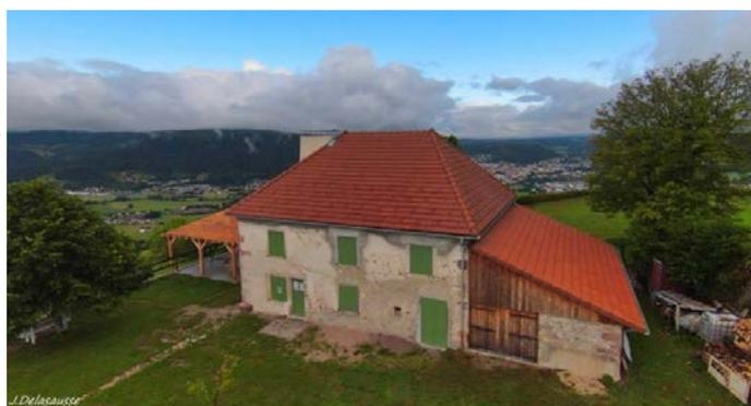
*Façade est, état actuel / printemps 2022 (photographie par drone / source : association Pour le Saint-Mont) Les retouches en ciments réalisées peuvent être à l'origine de points d'humidité à l'intérieur du bâtiment. La chaux est le matériau de base à utiliser pour les maçonnerie et les enduits.*
