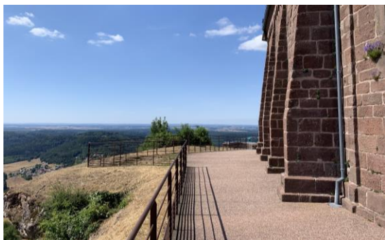
Le béton désactivé au pied de la chapelle empêche l'infiltration de l'eau dans le sol et l'évacue vers la roche
