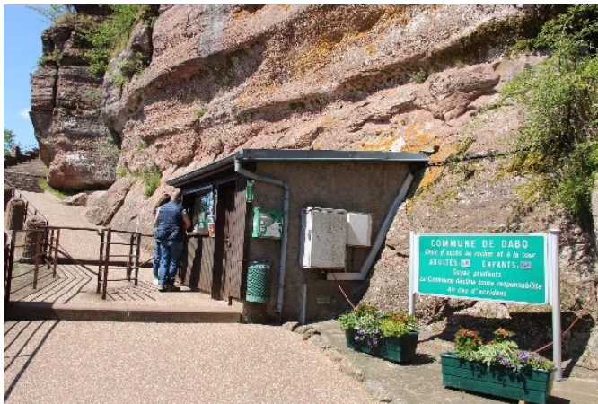
Requalifier la guérite d'accueil , utilisation du grès rose ou de matériaux complémentaires de celui-ci. Bannir le panneau les coffrets techniques et les jardinières en surplus.
