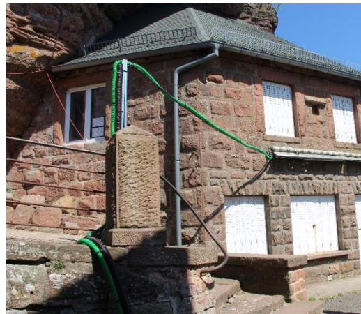
Enterrer et dissimuler les réseaux électriques très disqualifiants pour le site
