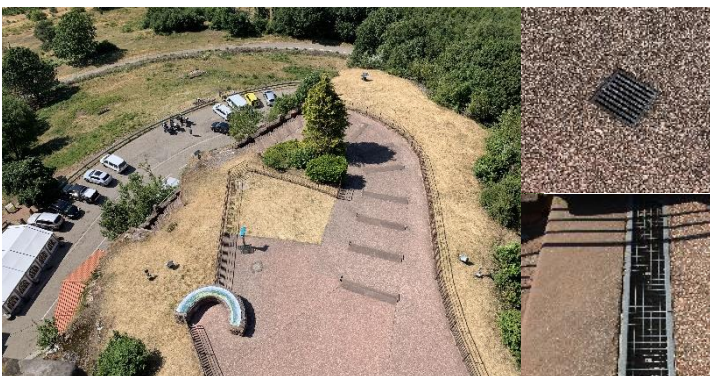
Etablir un diagnostic d'écoulement des eaux pluviales , la minéralisation du rocher semble guider l'eau vers les mêmes exutoires très écartés les uns des autres. Voir si les espaces végétalisés ou les puits et citernes peuvent être des espaces de gestion des eaux ou si ceux-ci ne sont pas adaptés.
