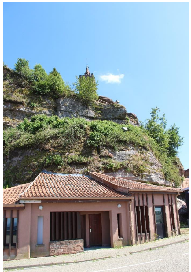
La végétation spontanée sur le rocher nécessite un entretien fait par des professionnels capables de déterminer les fragilités potentielles de la roche. Une formation auprès d'un employé communal ou de l'association peut être d'intérêt.
