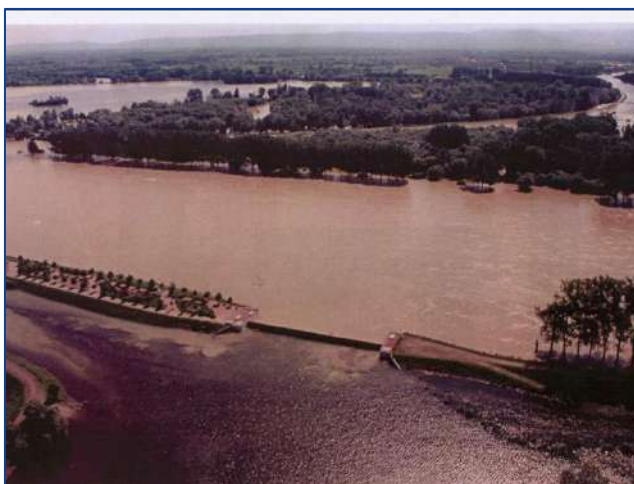
6 – Barrage à clapet fermé lors d'une crue du Rhin (VNF).
