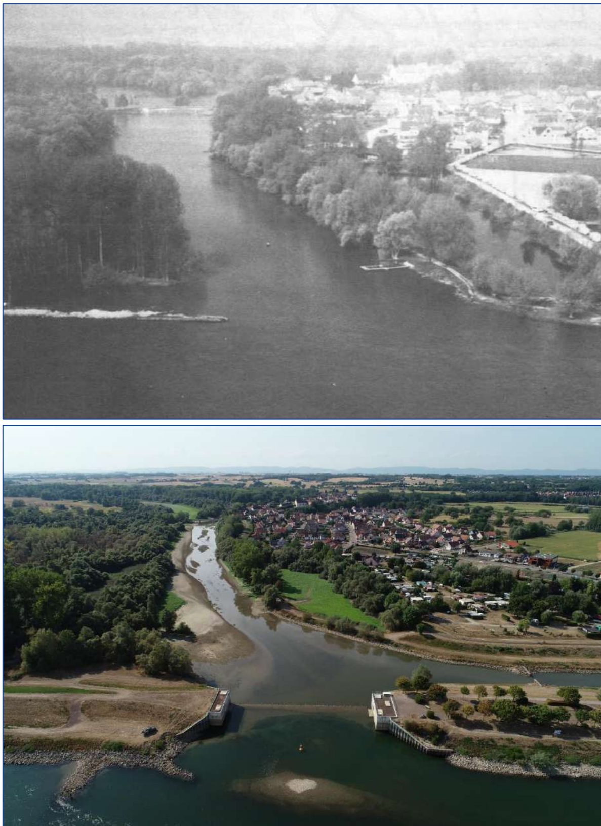
Figure 22 : Comparaison de l'embouchure de la Sauer avant et après les travaux de 1988-1993.
