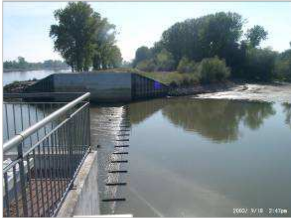
1 – Barrage à clapet, construit pour limiter les crues dans le delta de la Sauer, son utilisation écologique apporterait une solution au problème d'envasement.
