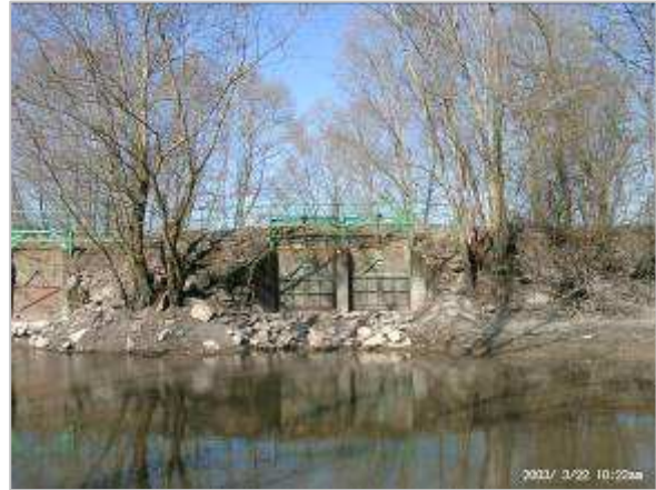
2 – Prise d'eau sur la digue qui encercle le Grosswoerth (2003). Une réhabilitation de cette vanne permettrait de redynamiser les milieux du Grosswoerth, notamment les roselières.
