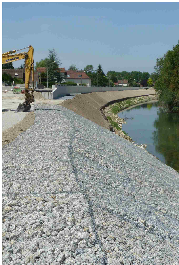
Travaux digues de Troyes
