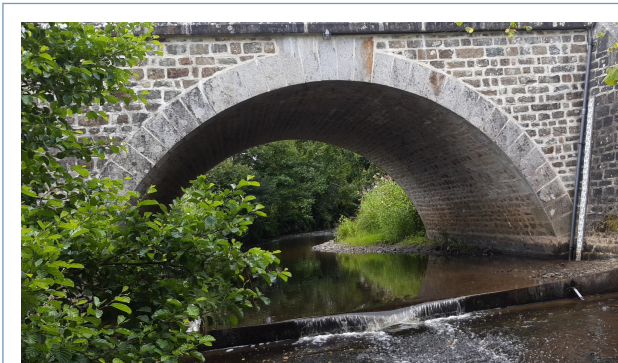
Concentration de l’écoulement sur une petite largeur en basses eaux : bonne sensibilité
