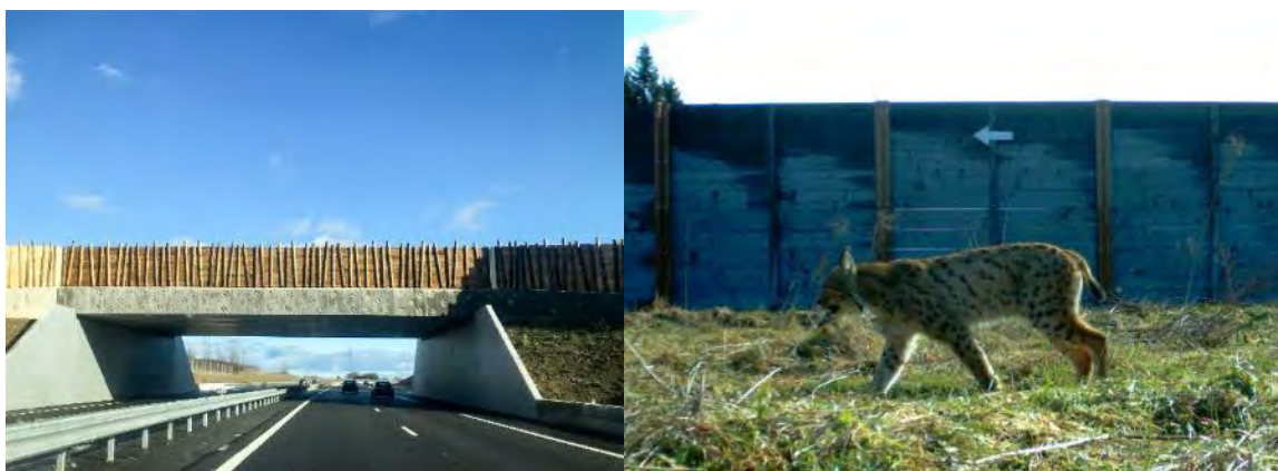
Exemple d'un passage à faune au-dessus d'une 2 x 2 voies (© OFB / S. Gatti). Les lynx peuvent utiliser ces passages à faune, et un engrillagement adéquat doit permettre de canaliser les déplacements vers ces ouvrages pour un franchissement sécurisé des obstacles, ici dans le Doubs (© FDC25).
