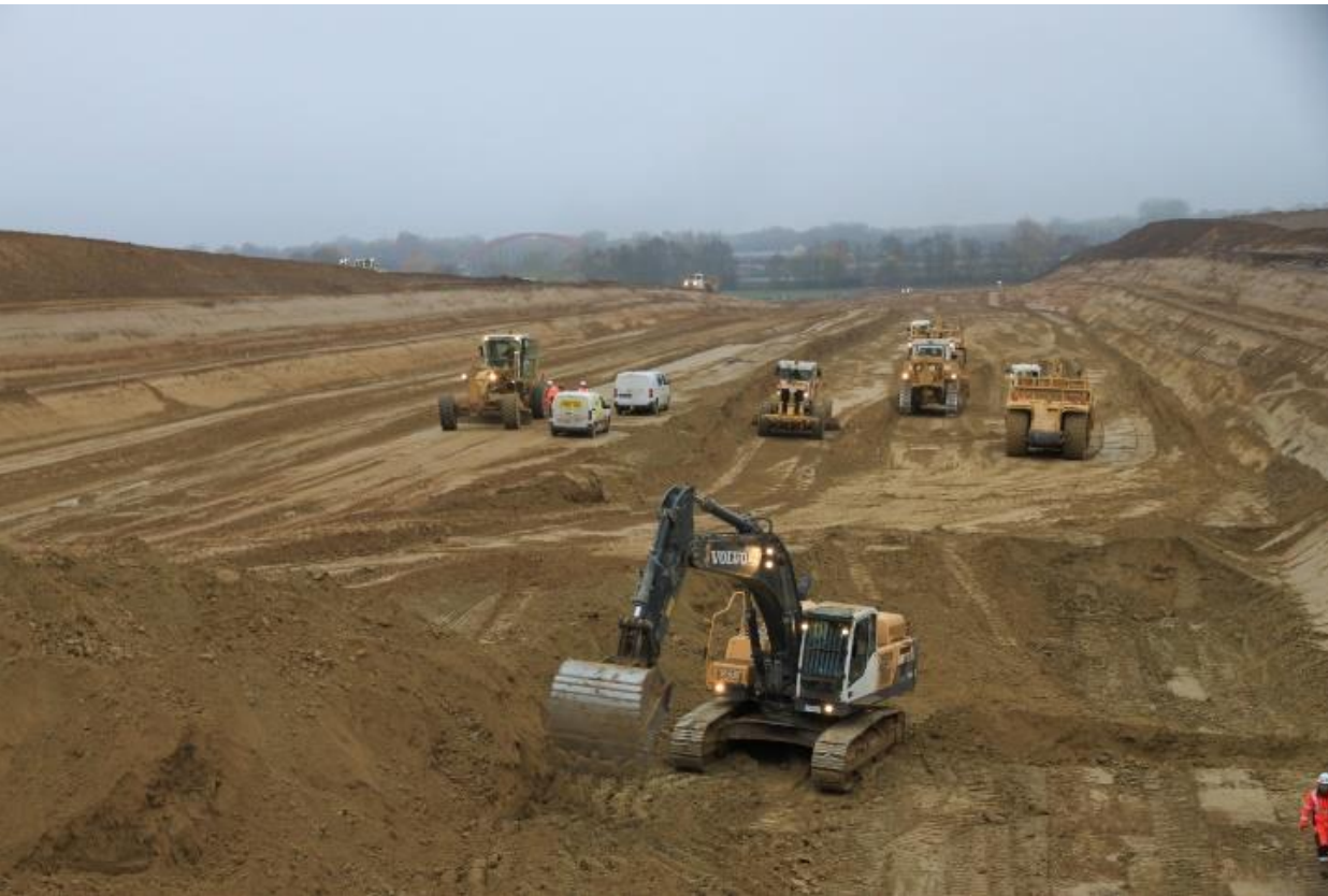
Terrassement de la tranchée couverte
