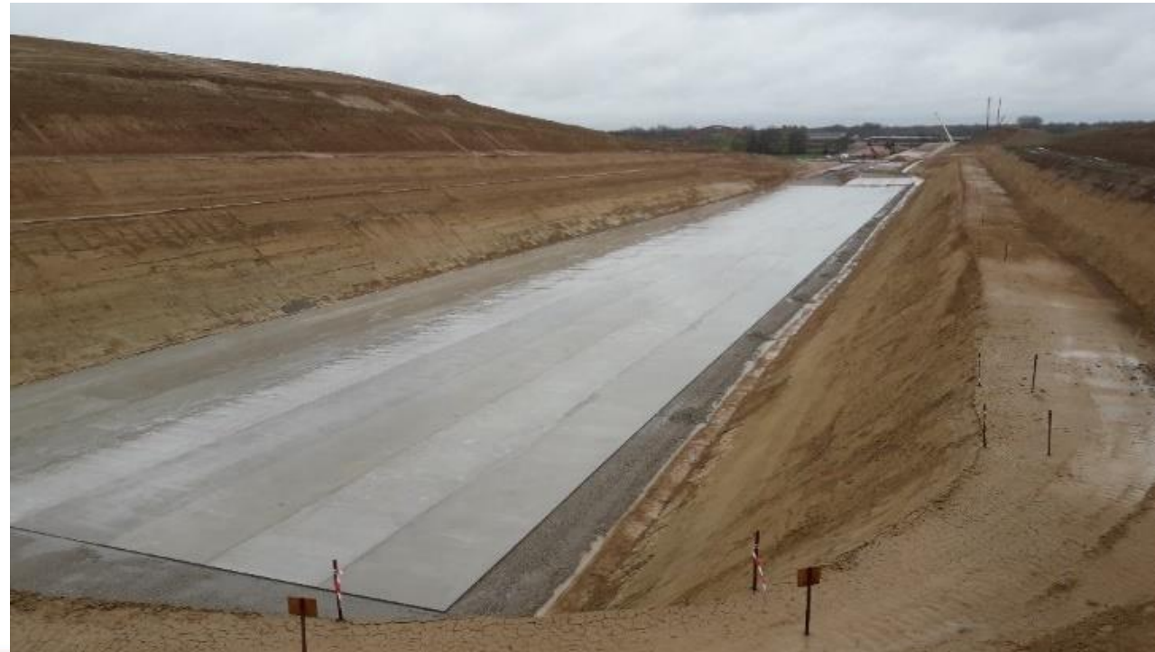
Tranchée Couverte de Vendenheim
