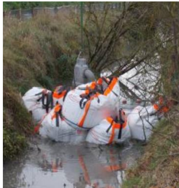
Mise à sec
