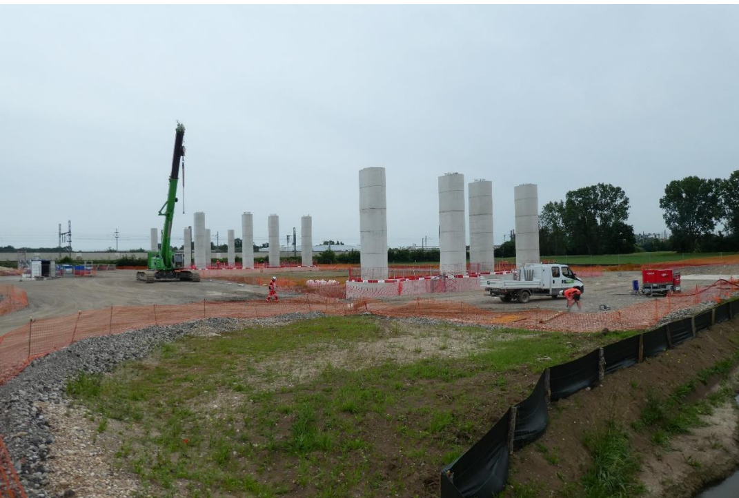
Viaduc de Vendenheim
