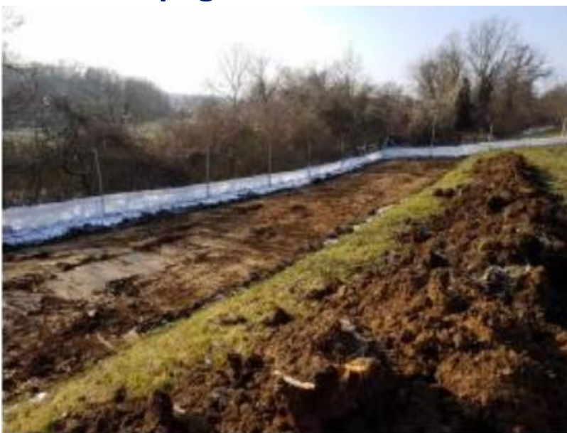
Décapage du site d'accueil
