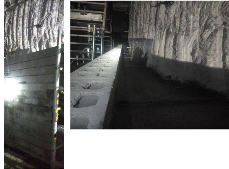
Coffrage longitudinal barrage 9b
