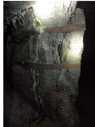
Pilier fracturé
