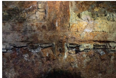
Vue des vis de liaison du cuvelage
