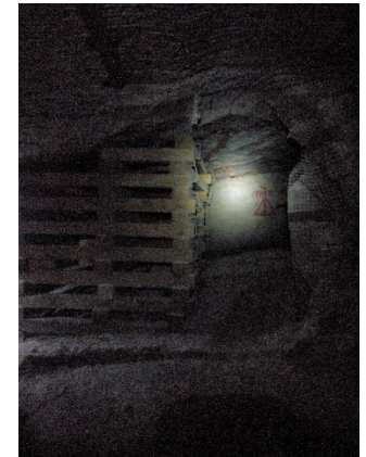
Pile de soutènement au droit de la recoupe aval
