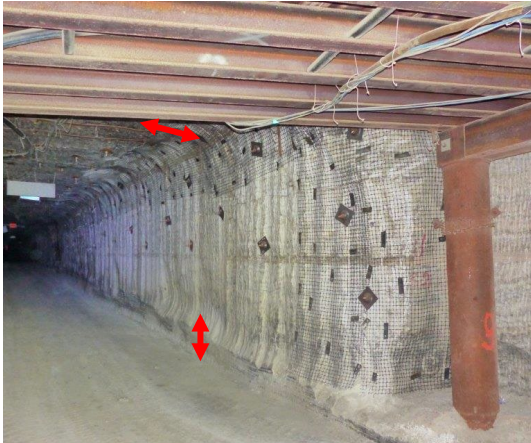
Remise au gabarit de la voie AJ1 T
