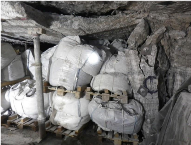
Gonflement des parements
