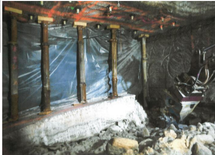
Soufflage du mur
