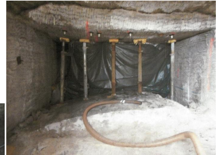
Détachement des dalles du toit
