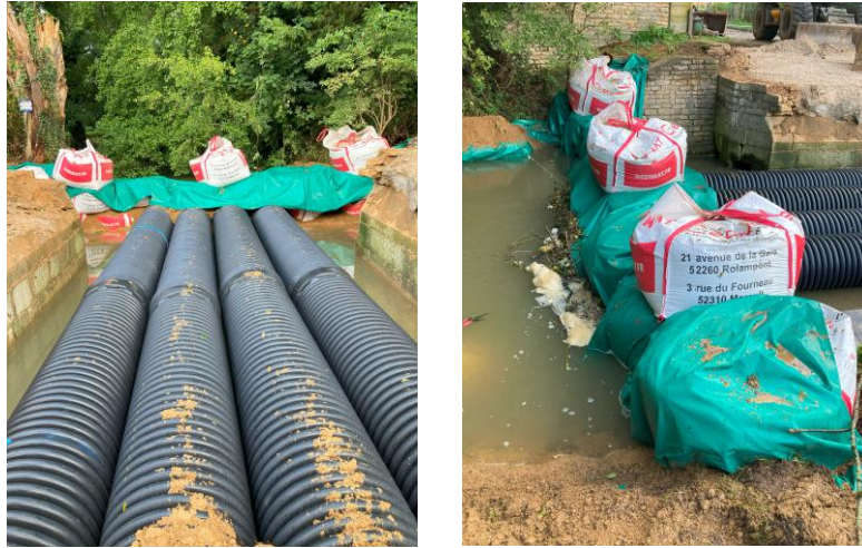
Exemple de batardeau réalisé
