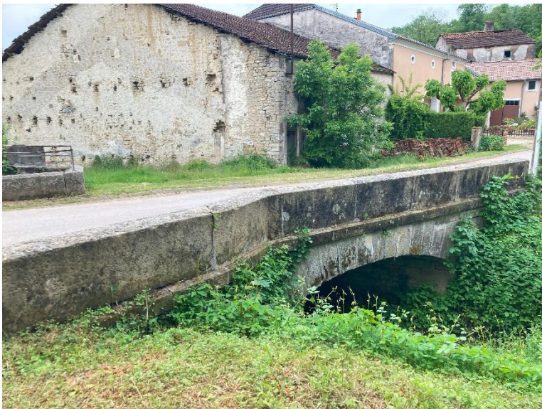
Photo du pont côté aval
