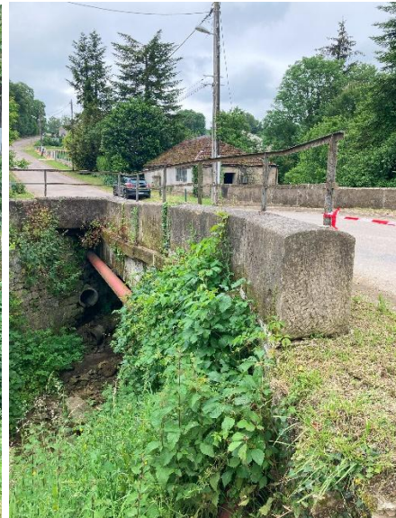
Photo du pont côté amont.
