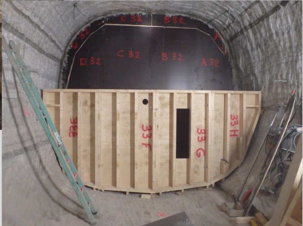
Coffrage en cours de montage
