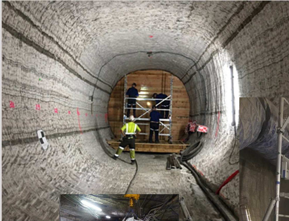
Coffrage d'appui du béton projeté
