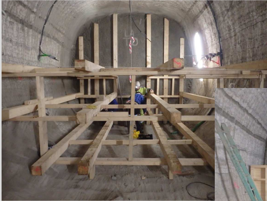
Structure d'appui entre les 2 plots
