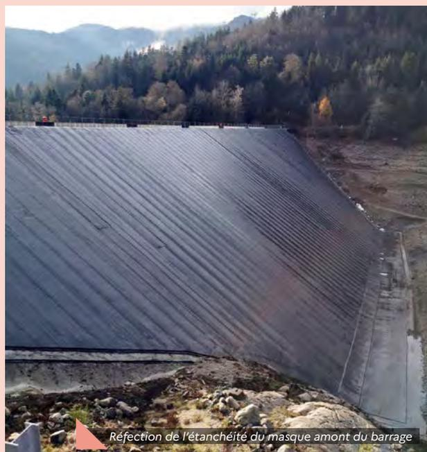
Réfection de l'étanchéité du masque amont du barrage
