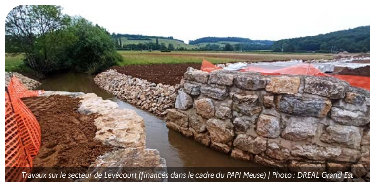
Travaux sur le secteur de Levécourt (financés dans le cadre du PAPI Meuse) | Photo : DREAL Grand Est
