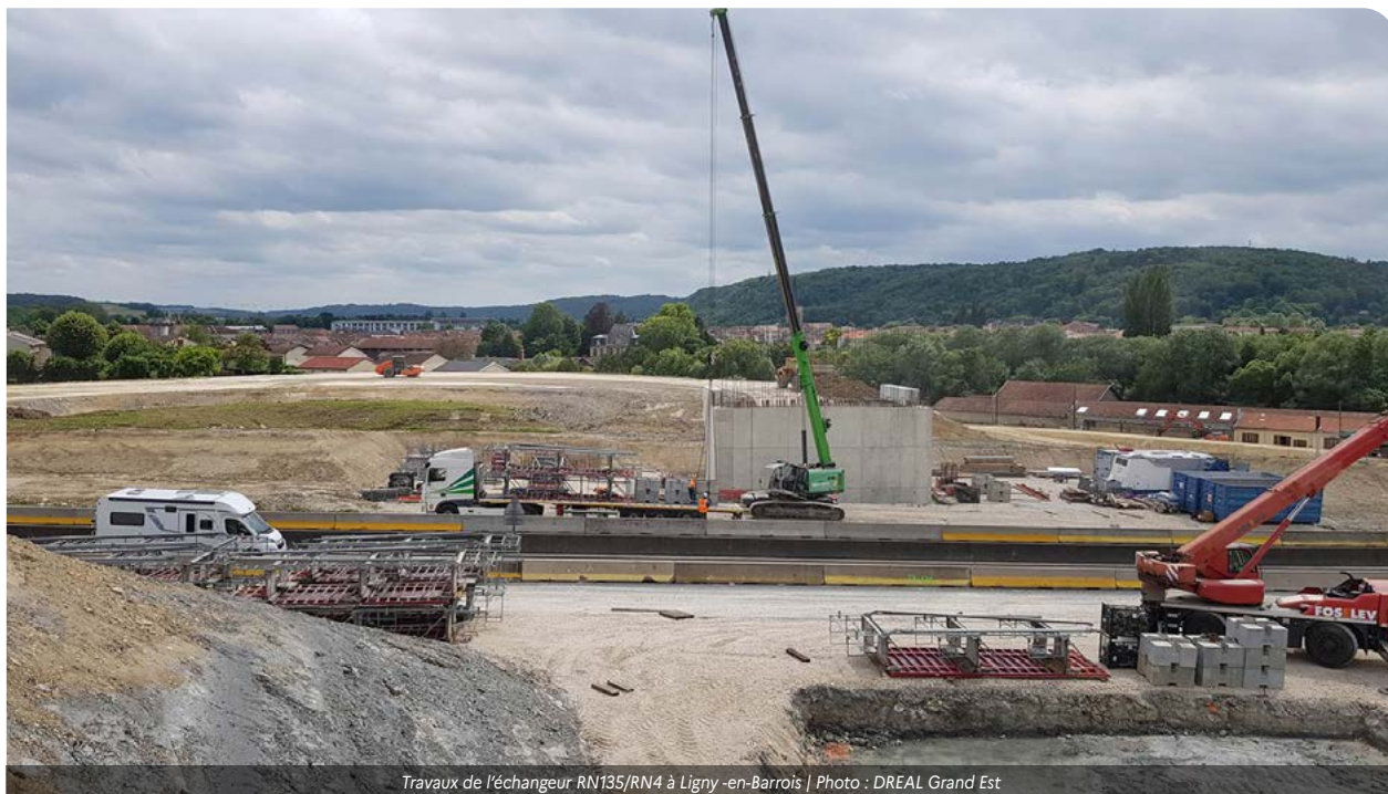
Travaux de l'échangeur RN135/RN4 à Ligny -en-Barrois | Photo : DREAL Grand Est
