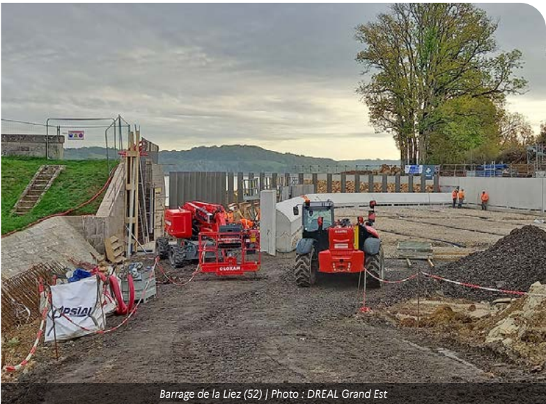
Barrage de la Liez (52) | Photo : DREAL Grand Est
