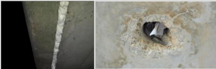
Photo 7C : Comblement des anfractuosités par du joint en mousse ou du journal, © Martin et al., 2023 & Aquageosphere, 2023
