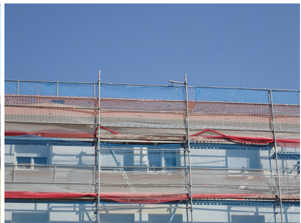
Les travaux sont en cours sur deux des cinq bâtiments du Carrefour de la Rethondes (isolation des façades faite ou en cours, changements des toitures)
