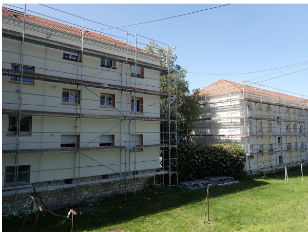
Les travaux sont en cours sur deux des cinq bâtiments du Carrefour de la Rethondes (isolation des façades faite ou en cours, changements des toitures)
