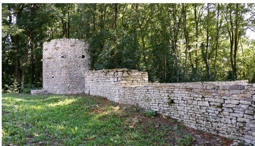
Mur d'enceinte et fausse tour
