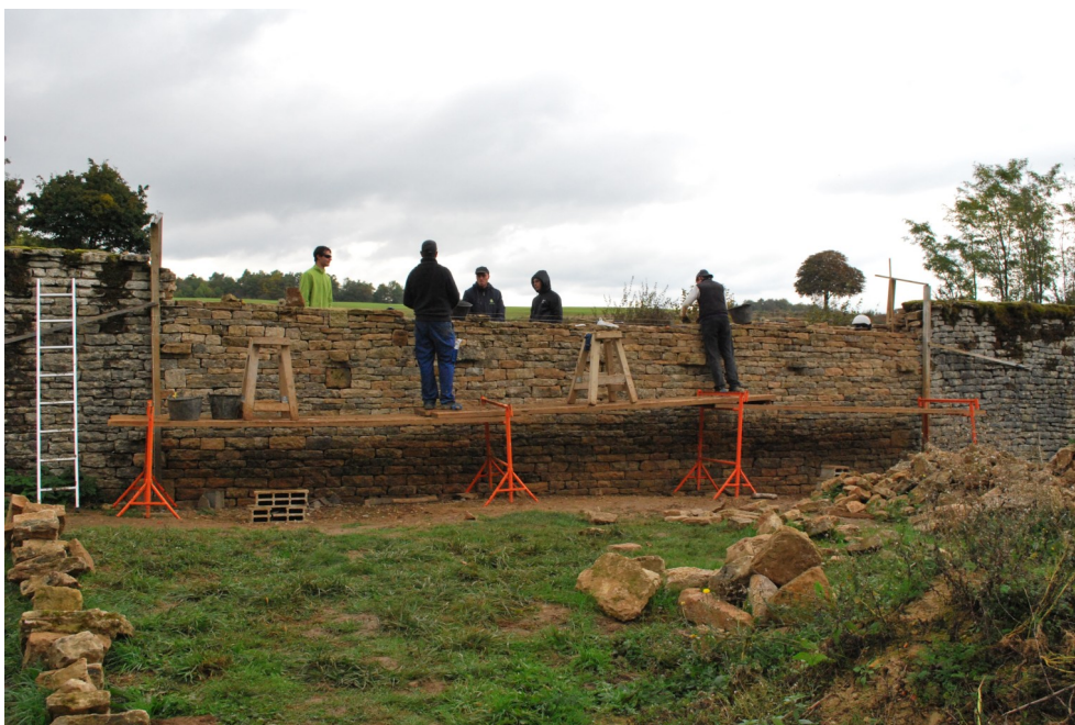
Réfection du mur nord du Clos de la Roche par un chantier d'insertion © JF Edme
