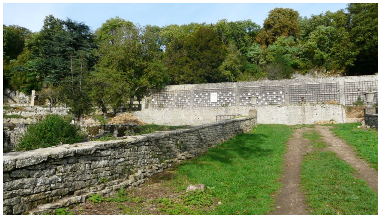
Rampe d'accès depuis la rue Joyeuse
