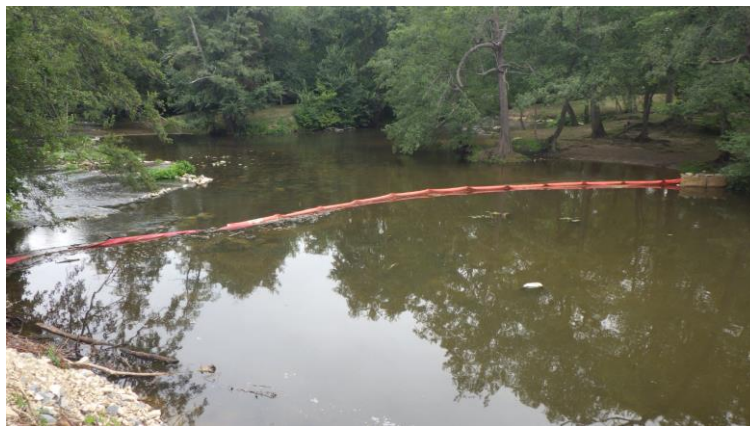
Figure 23 : Exemple de barrage anti-MES flottant
