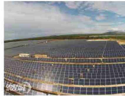
Centrale de Belvezet, Gard
