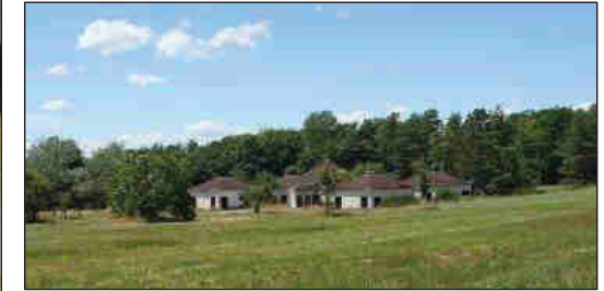
Bâtiment Nord ; Photo : S. Bellour
