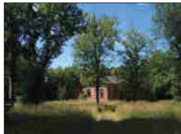
Bâtiment Sud-Ouest ; Photo : S. Bellour
