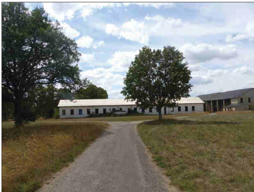
Bâtiment central à préserver
