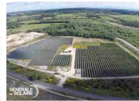
Centrale de Pujaut, Gard
