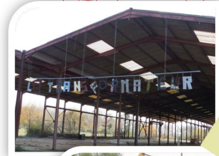
Friches industrielles; Transformateur Saint- Nicolas-de-Redon
