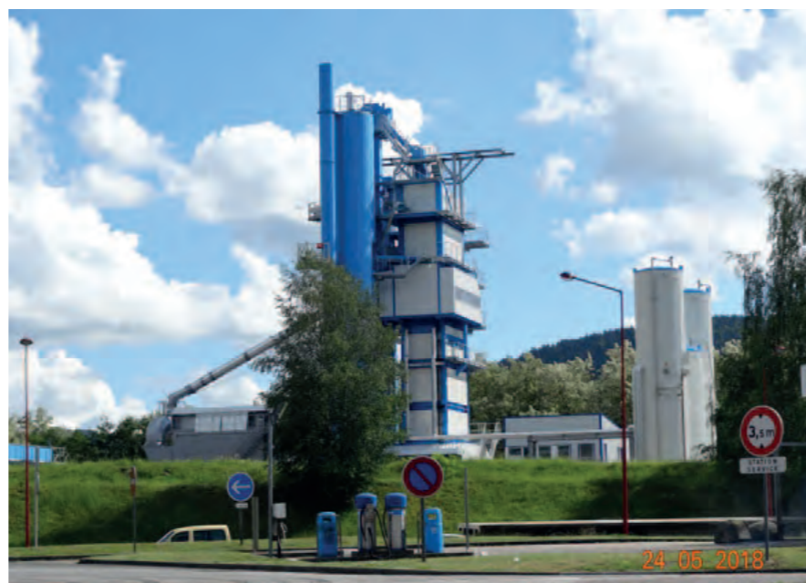
5. La nouvelle centrale à enrobé de Saint-Étienne-lès-Remiremont, près du centre commercial Leclerc. Les couleurs blanc et bleu sont prégnantes dans les vues sur le Saint-Mont
