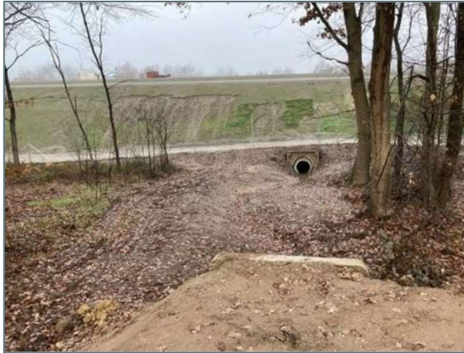
Maintien de l'alimentation en eau de la ZH enclavée
