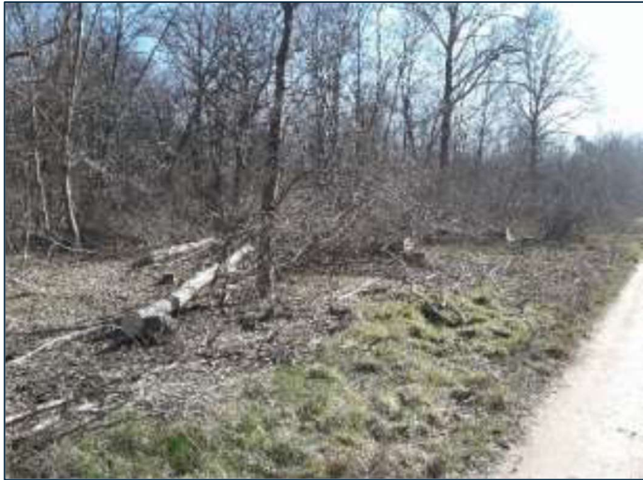
Abattage de sécurisation et étagement des lisières
