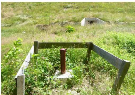
Photographie du piézomètre PZ1 (X 1047939 – Y 6852645).
