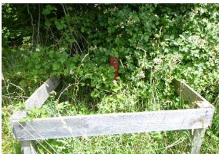
Photographie du piézomètre PZ11 (X 1048319 – Y 6852598).
