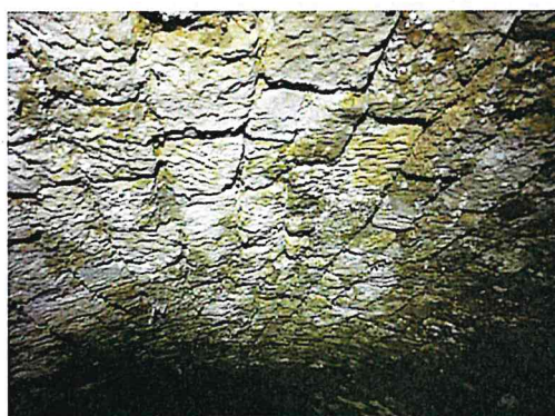
Entrée du tunnel du canal usinier
