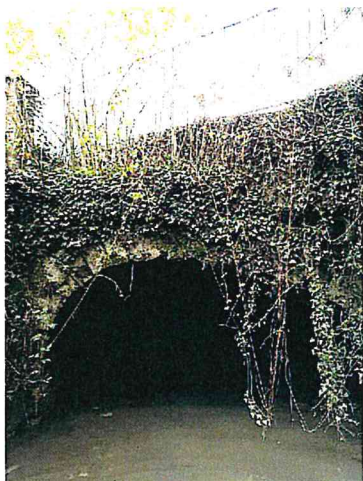
Amont du tunnel passant sous la route
