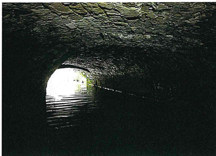
Sortie du tunnel du canal usinier
