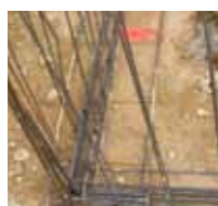
Nœud de chaînage - Continuité mécanique
