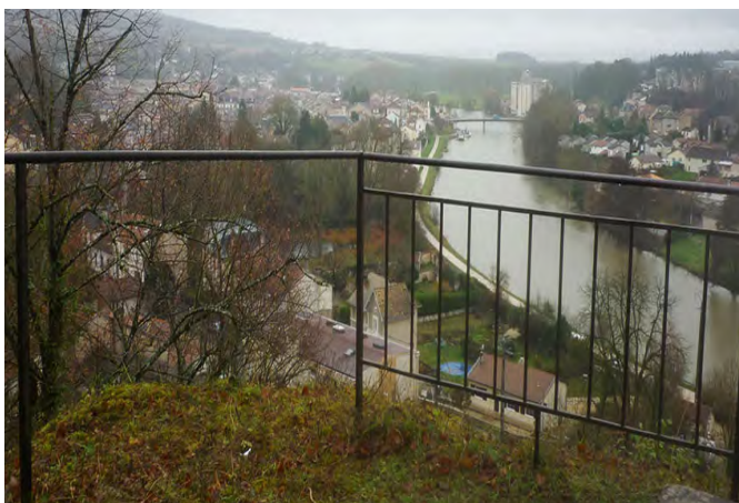
Seule la Roche du Calvaire est actuellement équipée d'un garde-corps.
