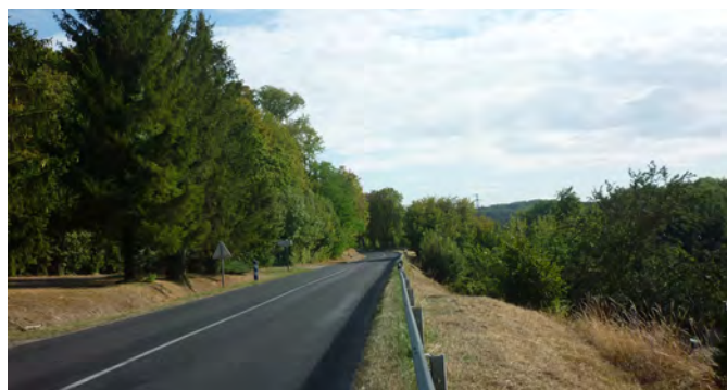
1. RD964, au nord du site classé.
