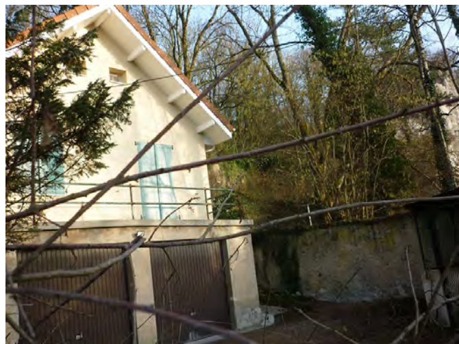
Une construction sans réelle valeur qui pourrait être démolie.
