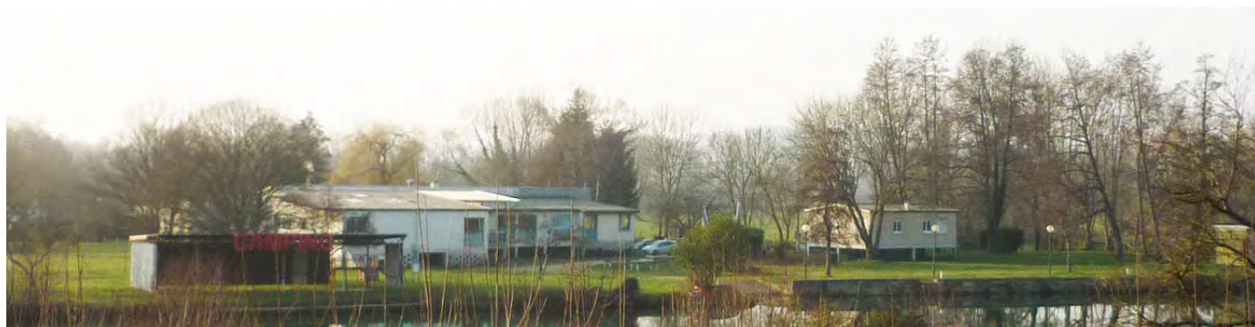
Le camping, sous gestion communale, appartient également à cette nébuleuse de constructions qui interfèrent directement avec le site classé. Les bâtiments, vétustes, ont un impact certain sur le paysage de la vallée. Une présence amplifiée par la teinte claire des volumes. Des travaux sont envisagés à court terme.
