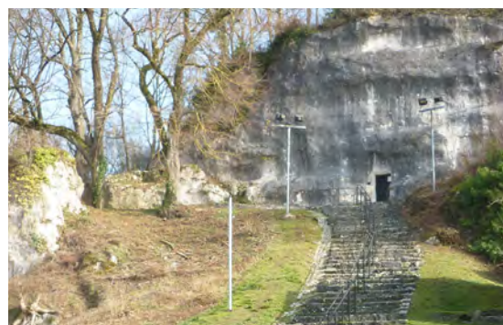
Dépose de l'éclairage (équipement ne fonctionnant plus).
