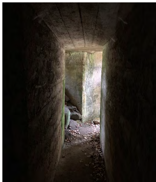
Les casemates de la Côte de l'Engin – 2019 Source T&P - FAP
